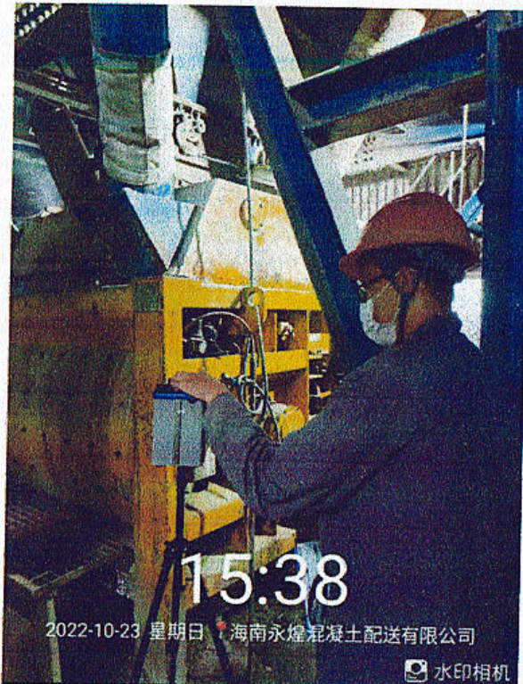
搅拌机粉尘检测 2022.10.23
