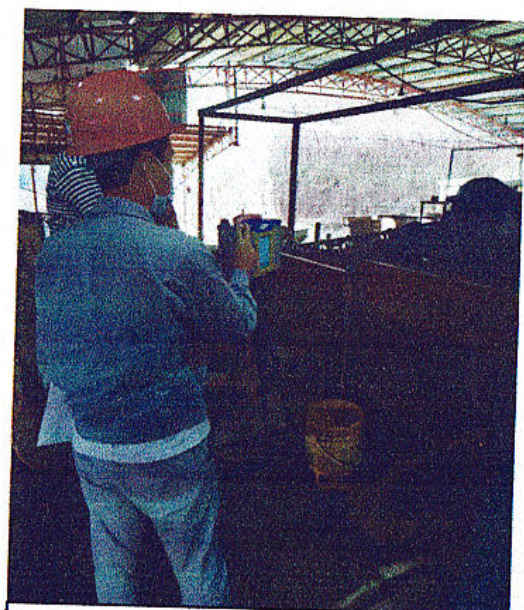
二次搅拌机粉尘检测
